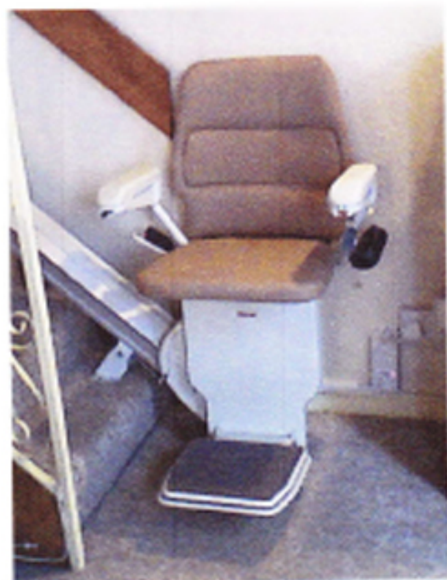
Stairlift in Situ.
